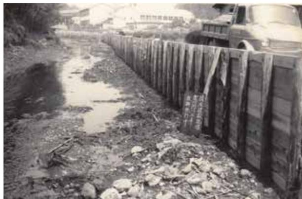
改修中の霞川 奥に第四小を望む、中下の板に「清水建設現場 霞川河川工事 板柵施行中」と読めます。板柵、蛇籠、現ブロック造と変貌しています。
