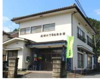
老朽化が進む6丁目自治会館
