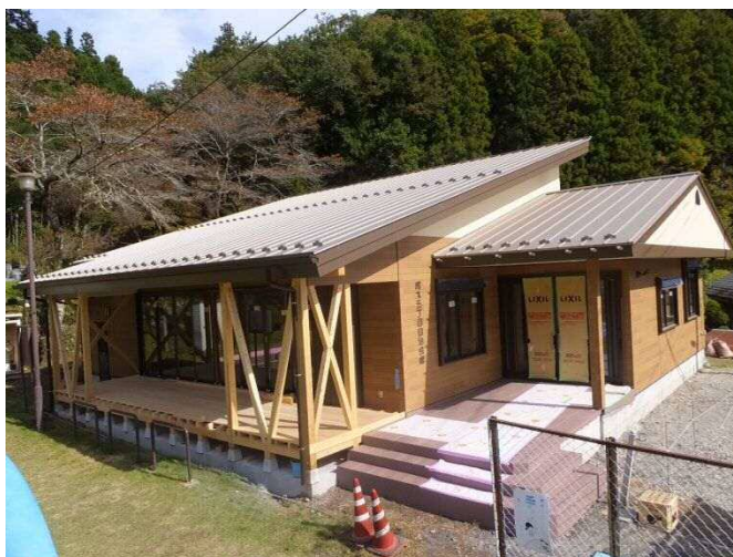
新自治会館（建設中 11月2日現在の写真）
