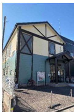
自治会館全体
